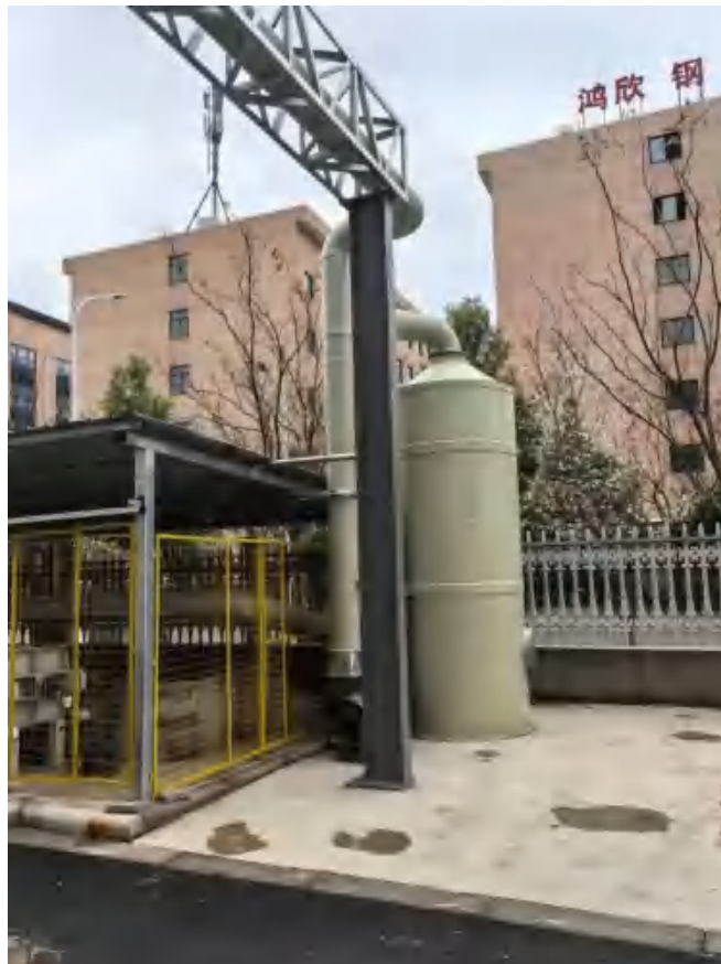
污水处理设施废气收集处理设施
